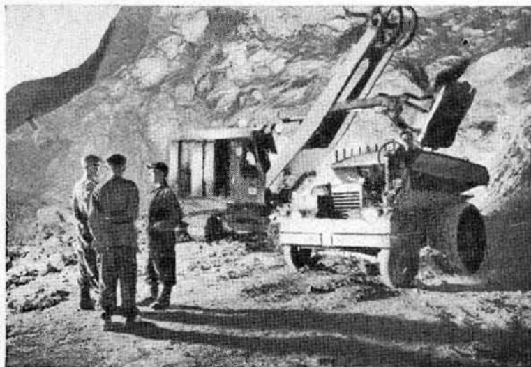
3. ábra Letakarítást végző kotrógép és dömper
