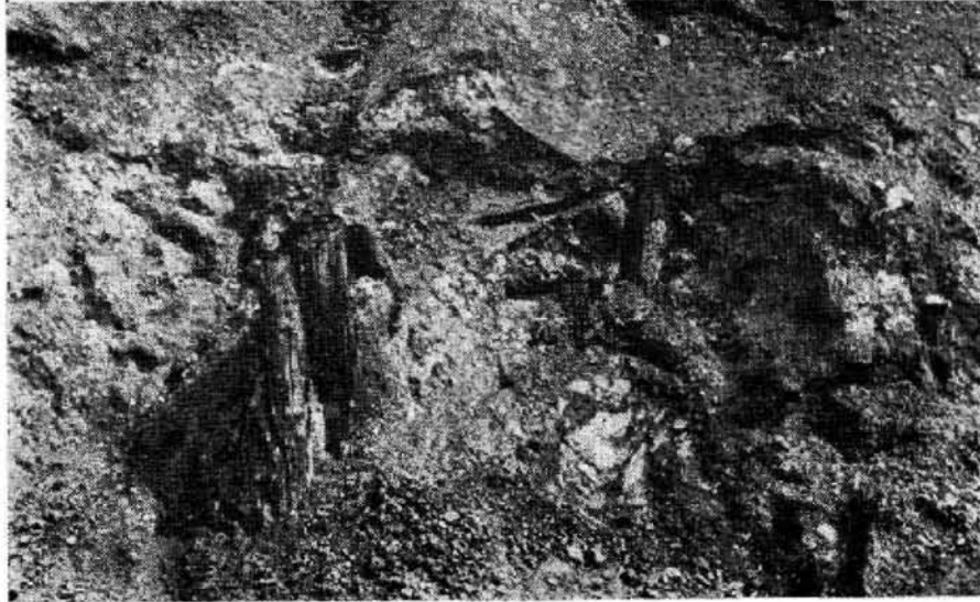
33. ábra. Külszíni fejtéssel feltárt középkori ácsolt vágatszakas
