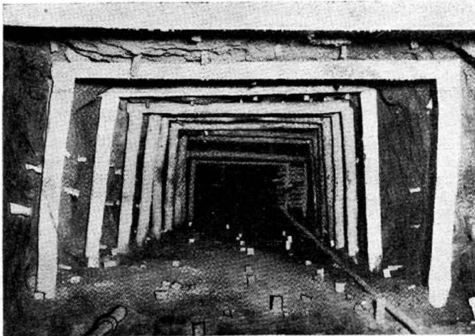
14. ábra. Pillérrobbantó fúrólukok egy osztószinti fejtésben
