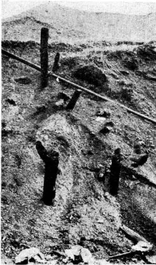
38. ábra. Külszíni fejtéssel feltárt régi bányavágat ácsolatai
