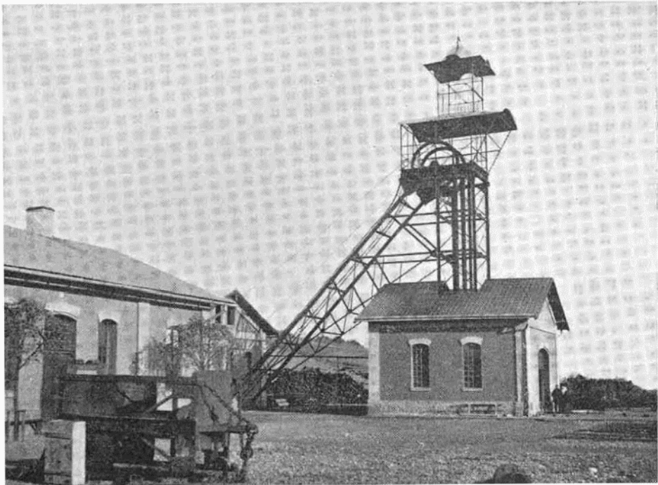
A rákosi szállító-akna kötélkorong-állványa.
