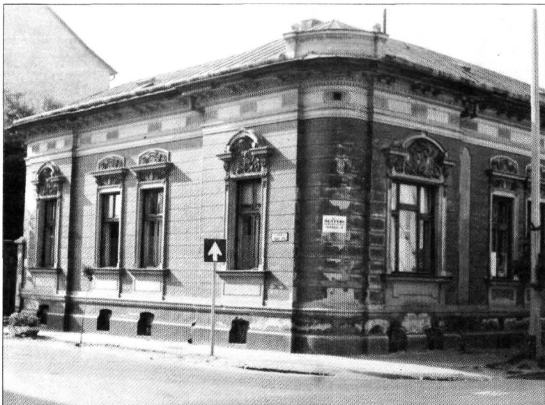
Az Iskola u. 1. sz. (lebontott) épülete
