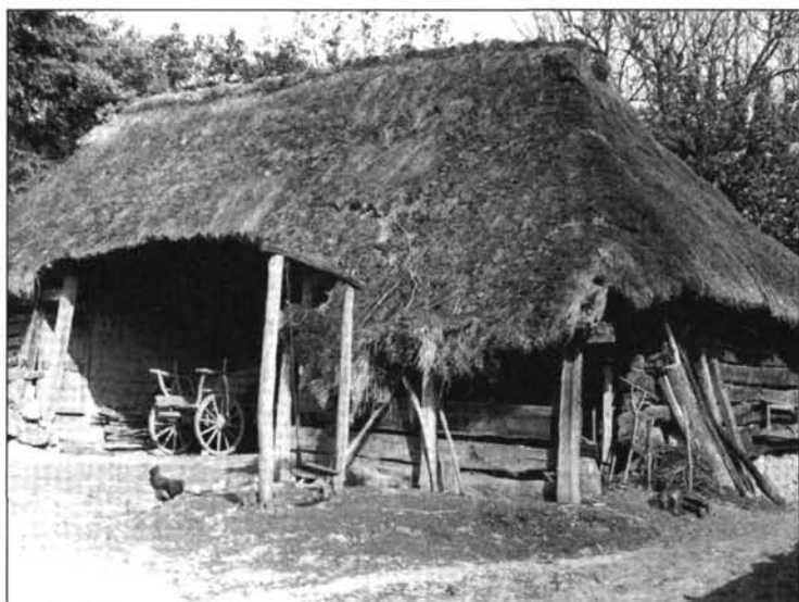
51. Boronapajta közepén a „szérüvel”, két oldalt két „pajtafiával”. Kávás, 1963.
