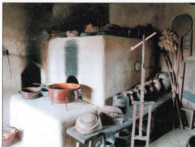
75. Füstökonyha részlete. Sárból-agyagból épült kemence, előtte tüzelőpadka, balra szobai kályha tüzelőnyílása.
