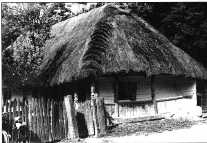
30. Sövényfalú, sáttortetős, zsúppal fedett, előtornácós lakóépület. Tüskeszentpéter, 1961.
