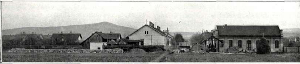
78. kép. Szivattyúház és tisztalok.
