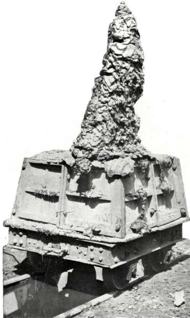
98 kép. Nagyolvasztó-salak a kocsiből kiforrva.
