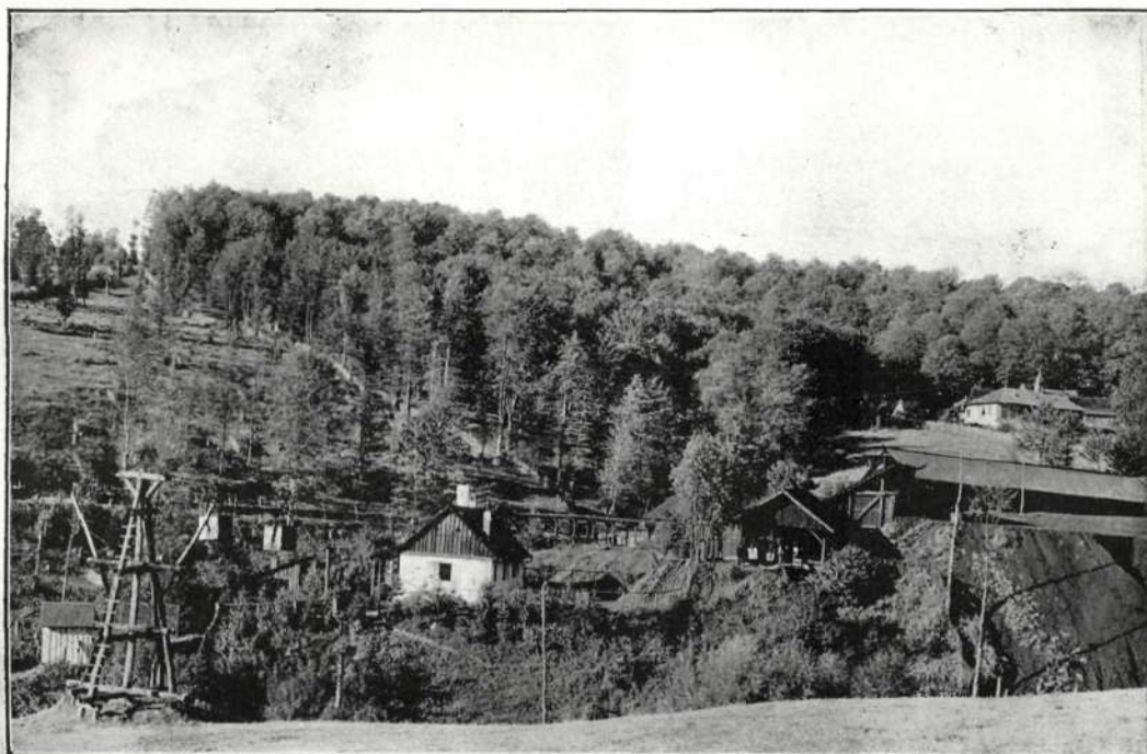
40. kép. Vádudobri kapcsoló állomás.
