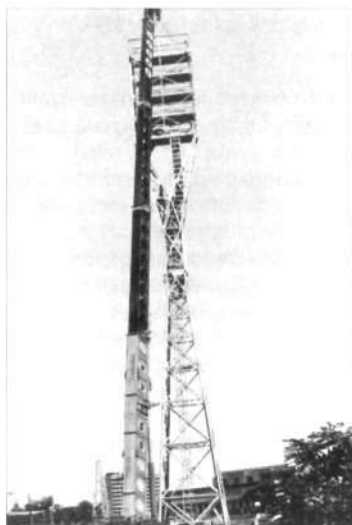
A Vasas Stadion világításának építése – fővállalkozó: TUNGSRAM Fényrendszer Iroda (1980-as évek eleje).
