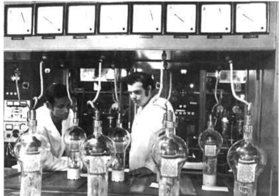
Nagyfeszültségű egyenirányítócső égetése, 1968 körül.
