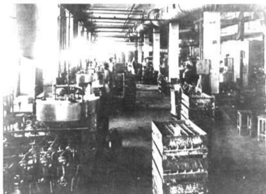
Izzólámpagyártás 24 fejű szivattyuautomatákkal, 1920-as évek.
