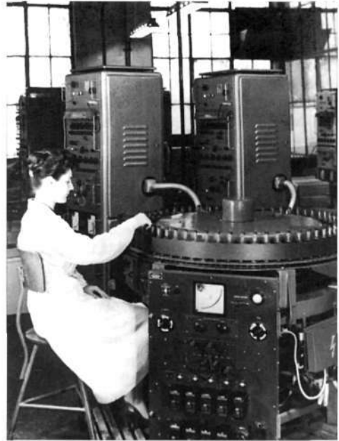
Rádiócső-mérő automata, 1960-as évek eleje.
