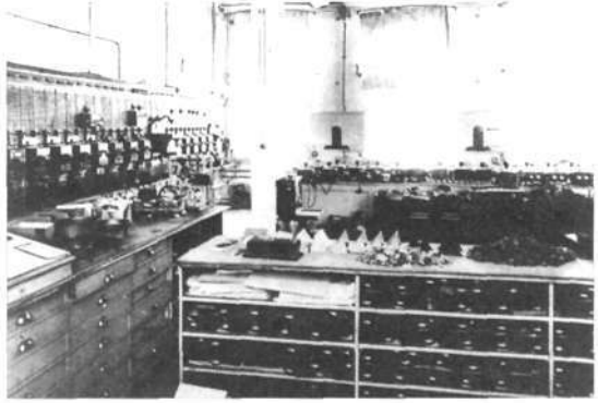
A telefonkészülékek ellenőrzésére szolgáló berendezés 1925 körül.
