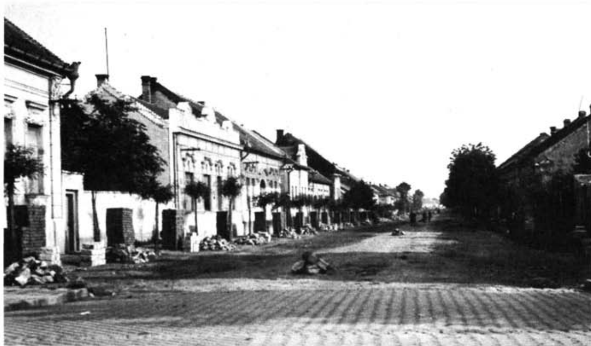
201. A Palotai út keramitburkolata készül az 1930-as évek végén. (Molnár Tibor felv.) P
