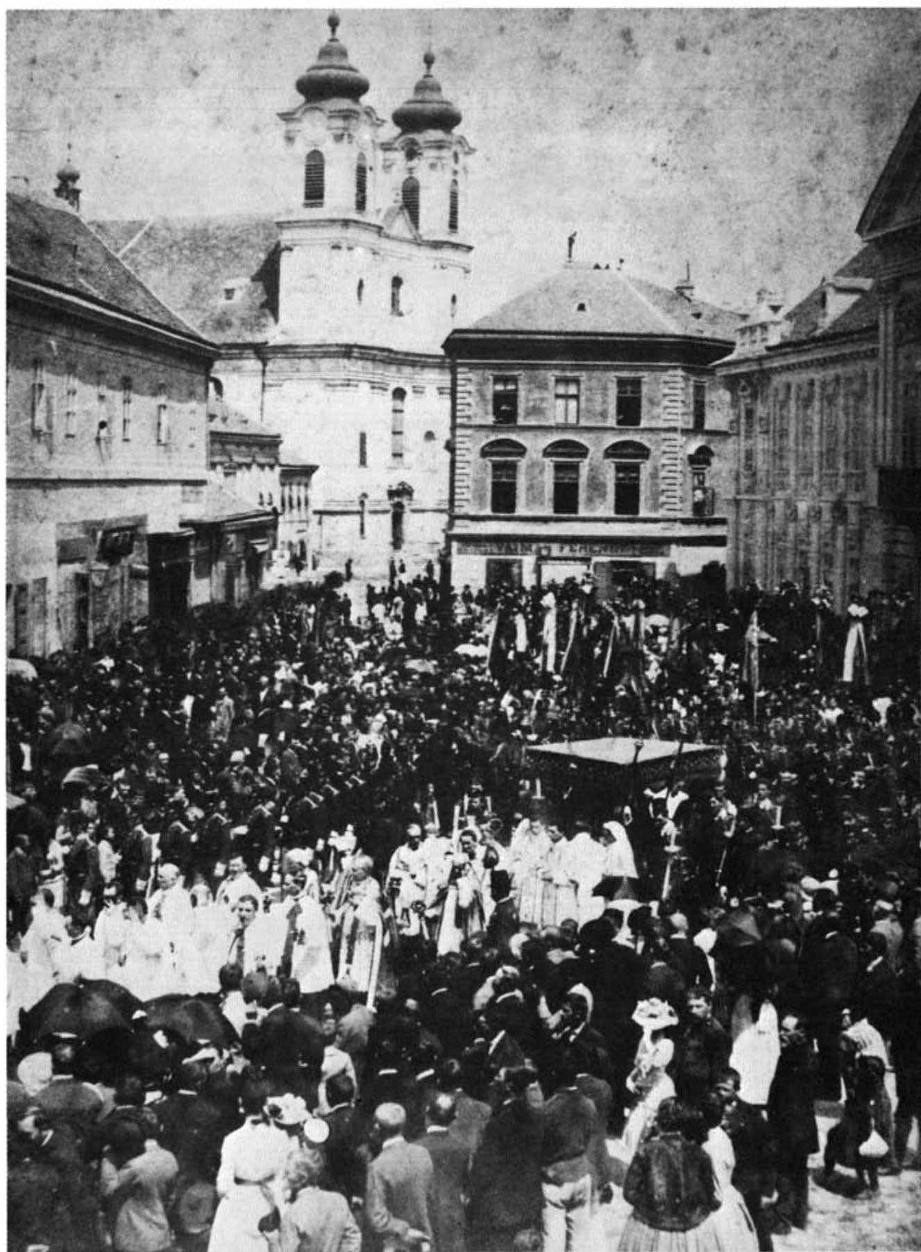
28. Úrnapi körmenet, 1888. A ferences rendház mellett még földszintes ház látható, amelynek helyén épült később a ferencesek bérháza. P
