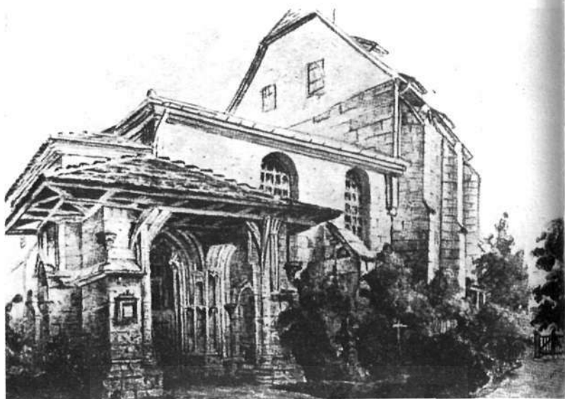
A weingarteni templom, ahol Schiller esküvője volt
