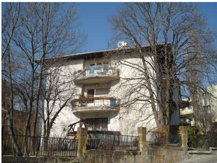
Fenti épület a Fenyő utcai oldalról. /forrás: panoramio.com/
