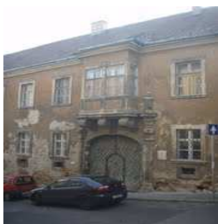
Pala utcai épület
