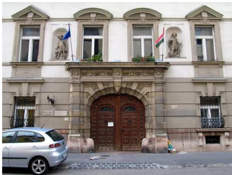
Úri utca 54-56. levéltári épület homlokzata /forrás: panoramio.com/
