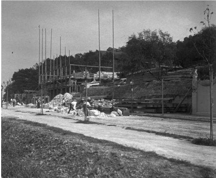
A vörös villa építése.
