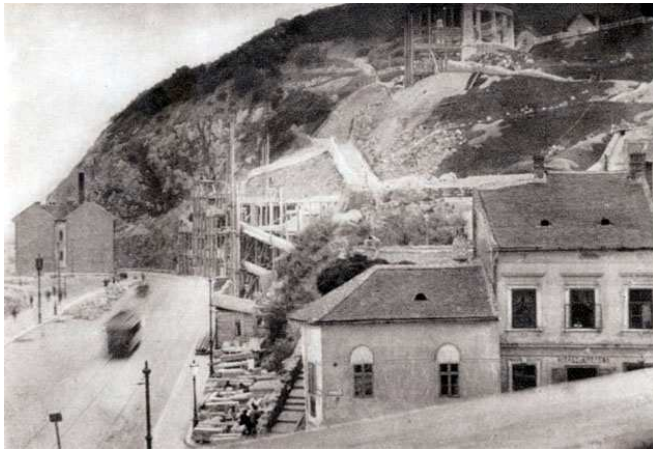
Szent Gellért szobor és a támfal építése /forrás: budapestcity.org
