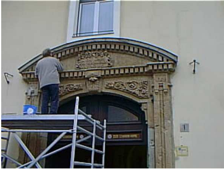
Várfok utcai kapu restaurálás közben. /forrás: ahomlokat.hu/
