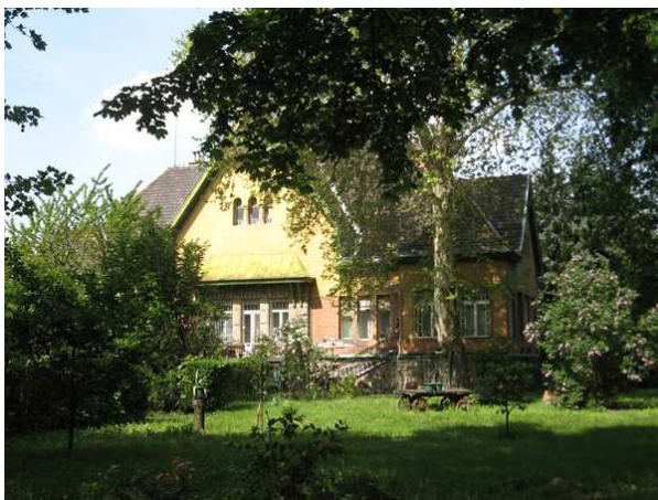
Egy a vezetőség számára épített villa
