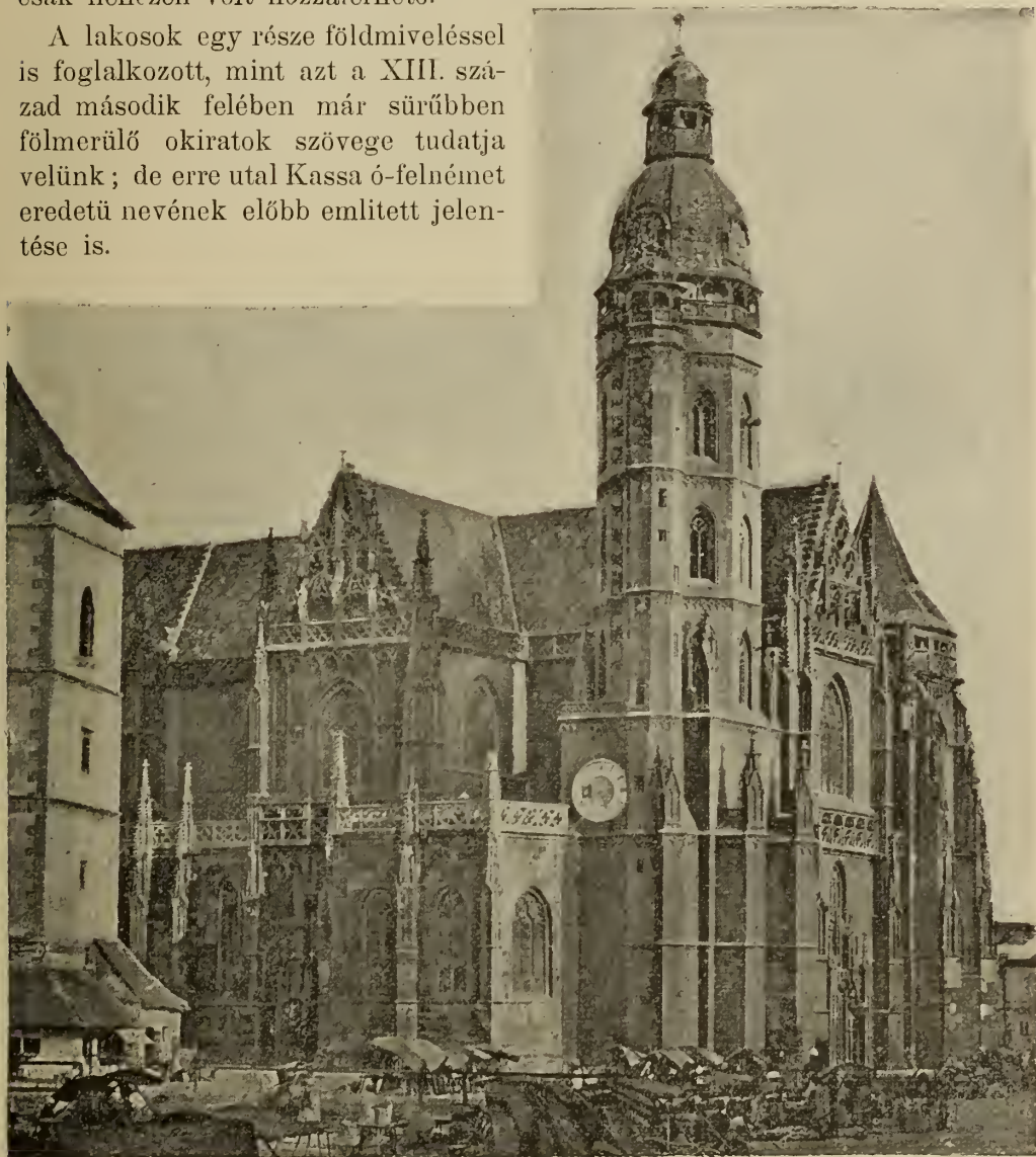
KASSA. — A DÓM ÉSZAKRÓL A RESTAURÁLÁS ELŐTT.
