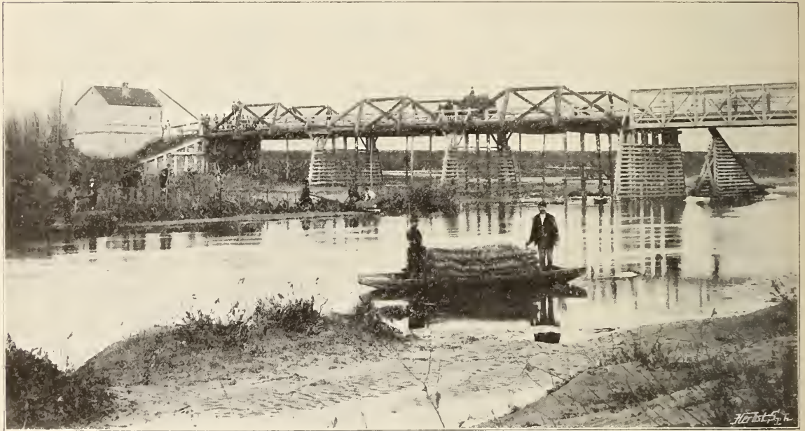
PARTVÉDŐ MUNKÁLATOK A KOMÁDI HÍDNÁL.
