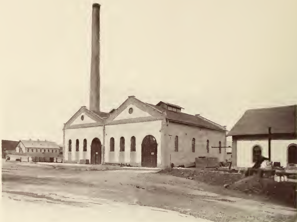
Tokod. — Az általános kőszénbánya társaság villamos középponti épülete.
