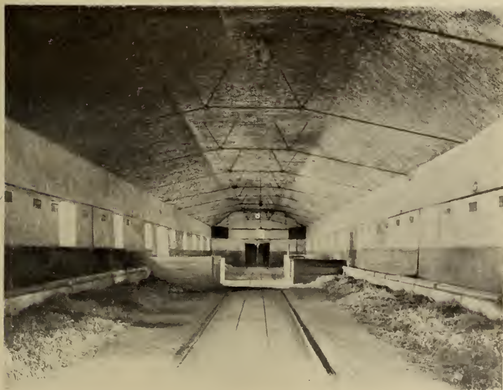
Gróf Pejacsevich Mikó Endre újszerkezetű, oszlopnélküli tehénistállója az apáti majorban.
