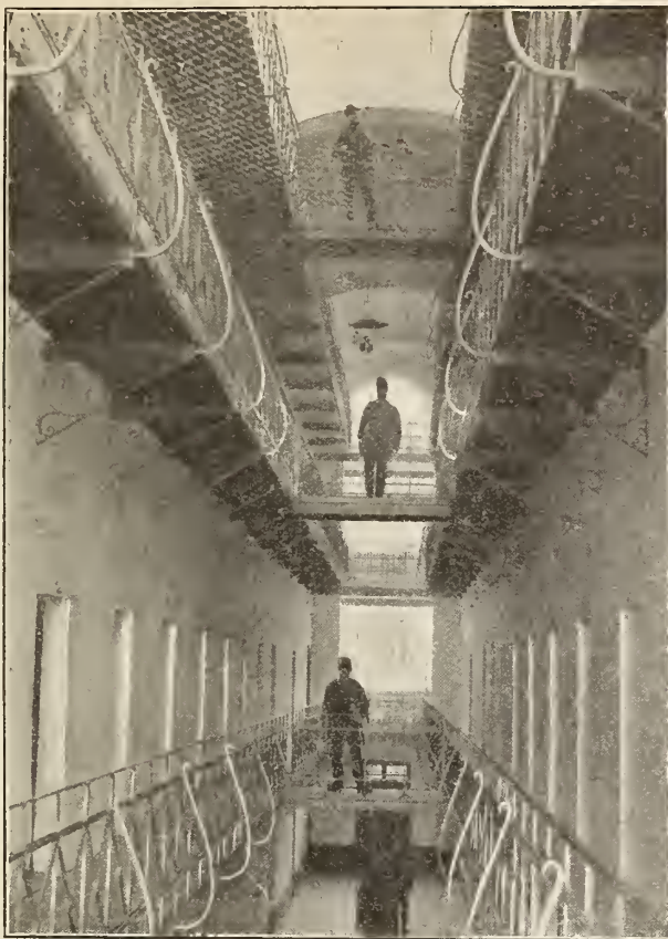
A TÖRVÉNYSZÉKI FOGHÁZ BELSŐ UDVARA.
