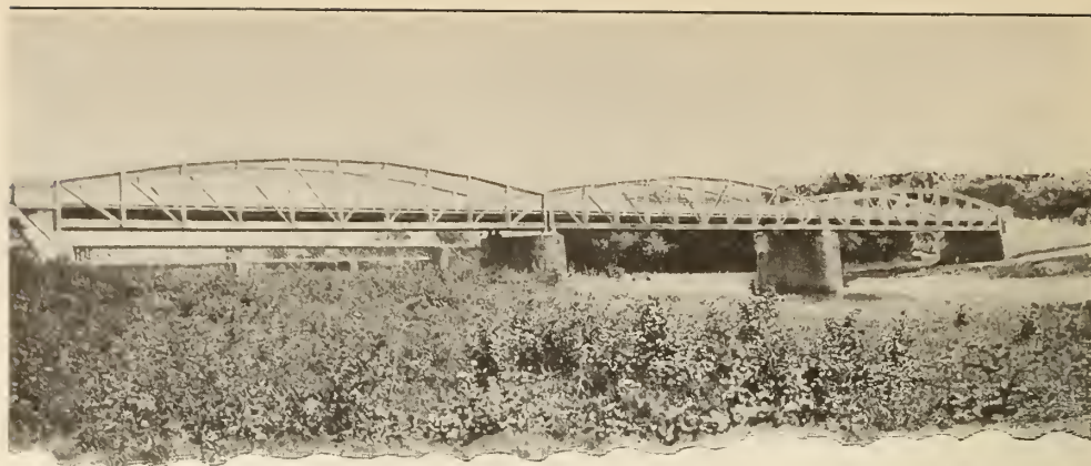
A RAKAMAZI VASÚTI ÉS KÖZÜTI HIDAK.
