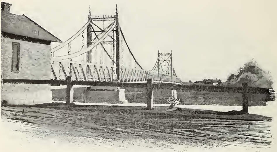
A tokaji közúti vashíd.
