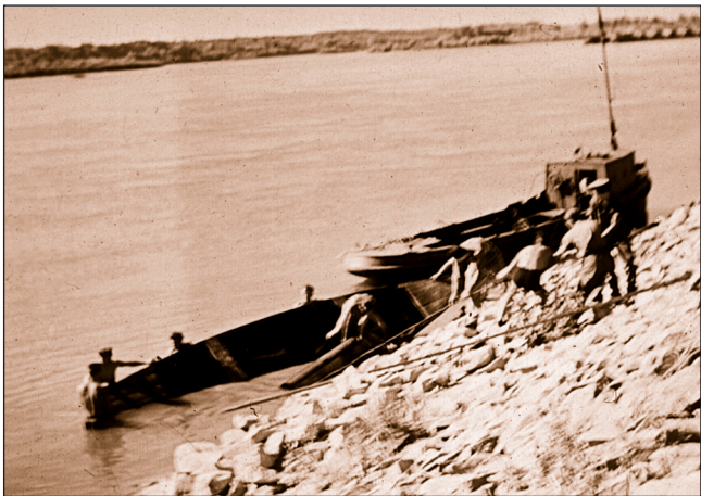
217. ábra: Az aknát vízbe merített csónakból kigördítik a gátoldalra (B. J.)
