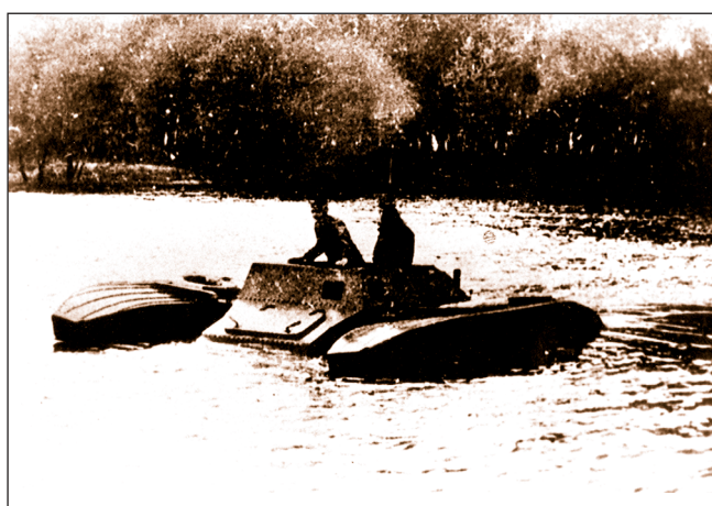
98-99. ábra: A W.R. Rt.-ben fejlesztett V-3 harckocsi a felkapcsolt két úszópontonnal 1936. augusztus 18-án 8,5 perc alatt kelt át a Dunán Háros-sziget és Csepel között. A löveges torony nincs felszerelve, ez volt az első folyami harckocsiátkelés Európában (K. P.)
