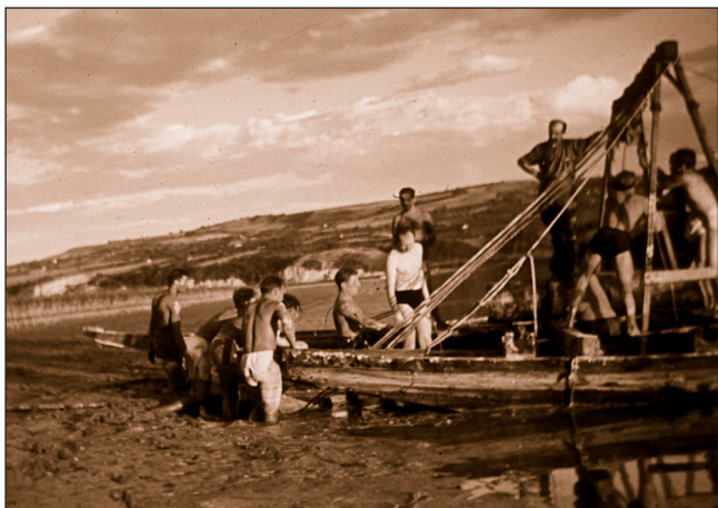
212. ábra: Az emelőtagot a második akna mellé állítják. A katonák az iszapban állnak (B. J.)
