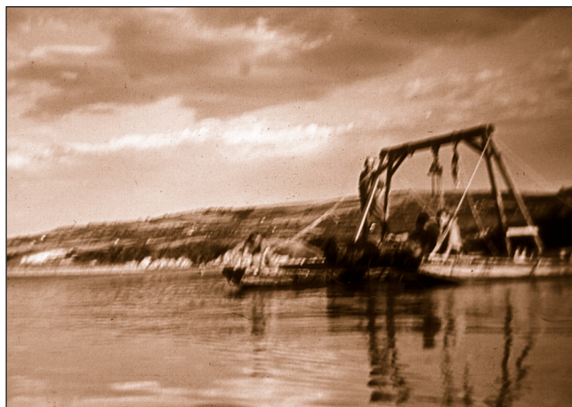
210. ábra: A Nagy Sándor folyamőr kapitány osztaga által összeszerelt fa emelőtag a két kiemelt aknával a Dunagárdonyi partra úszik (B. J.)
