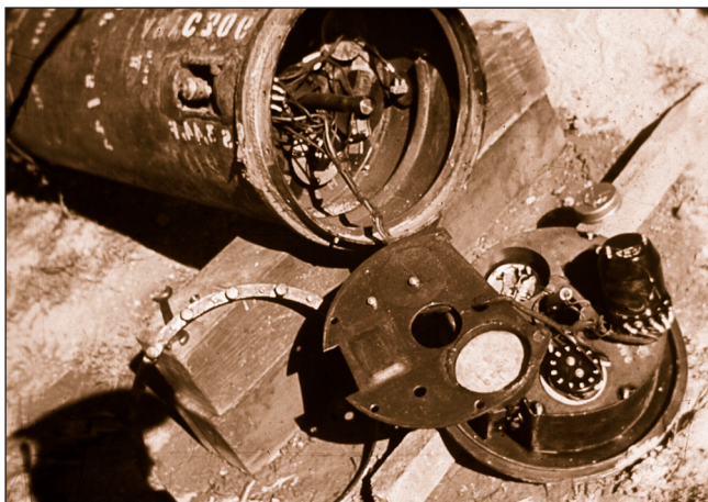
202. ábra: A brit C-306 típusú áthaladást számláló akna műszerrésze kibontva Újpesten (B. J.)
