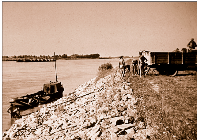
218. ábra: A mentesített aknát a teherautóra erősített drótkötéllel húzzák fel a partoldalra (B. J.)
