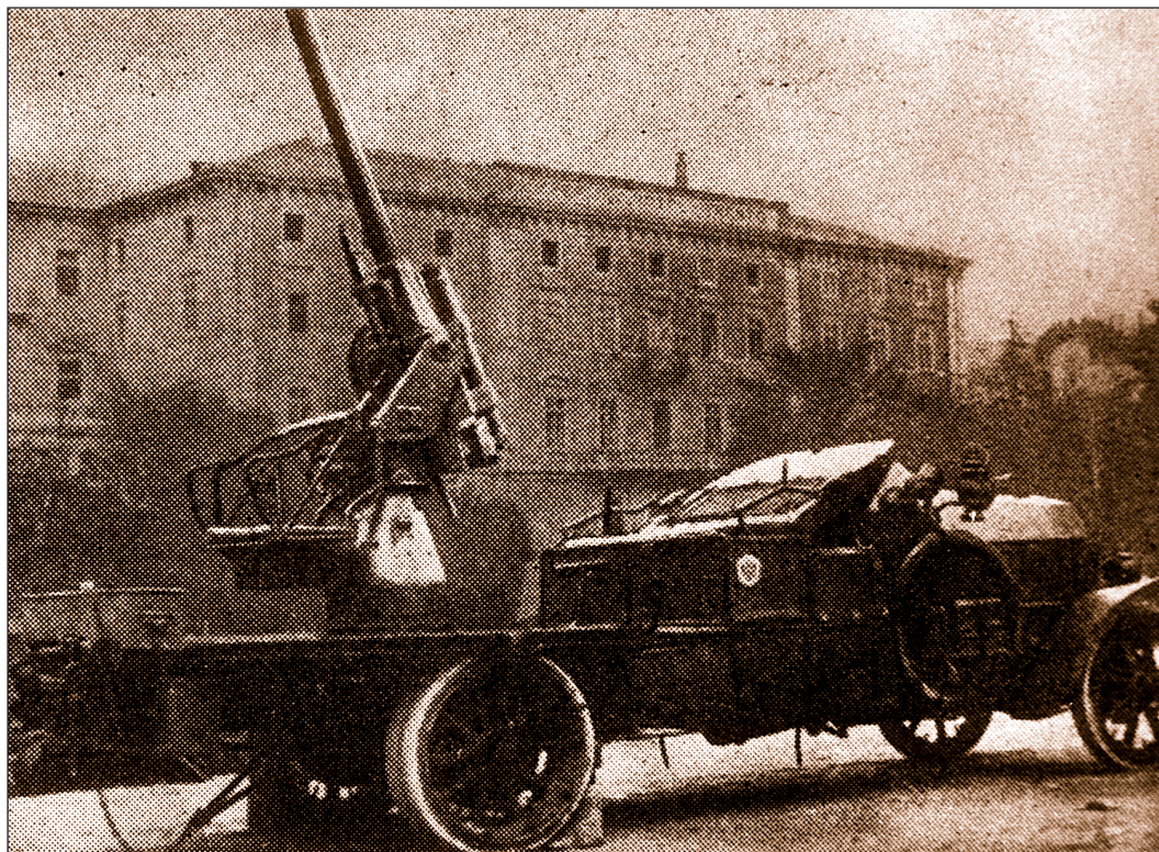
131. ábra: A régi 1905/8 M. légvédelmi ágyú egy Rába V. gépkocsi alvázra szerelve 1929-ből (S. Gy.)
