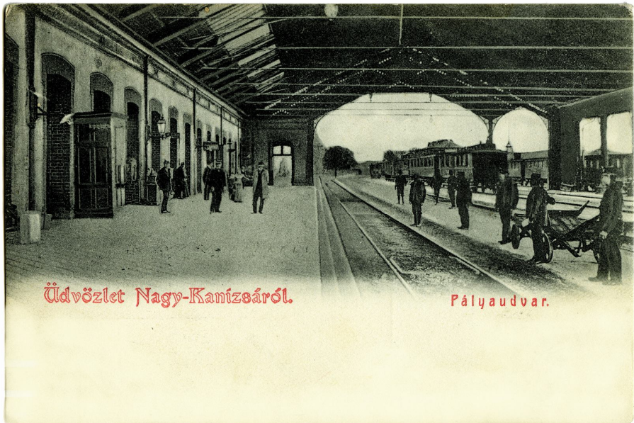
A vonatfogadó csarnok
