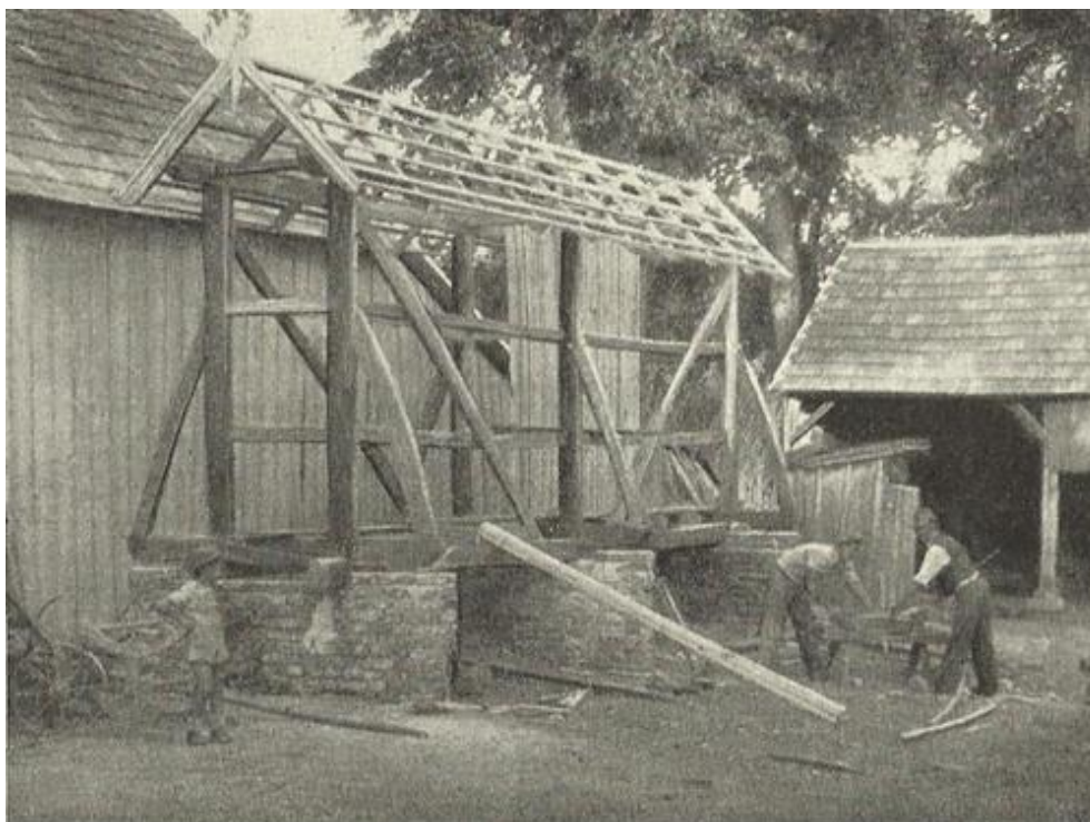
80. kép. Léces kukoricagóré építése (Szill, Sopron m.)
