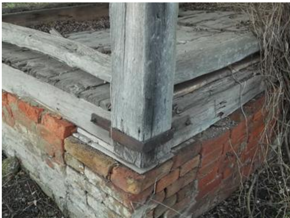
78. kép. A góré függőleges gerendájának rögzítése az alsó deszkázáshoz
