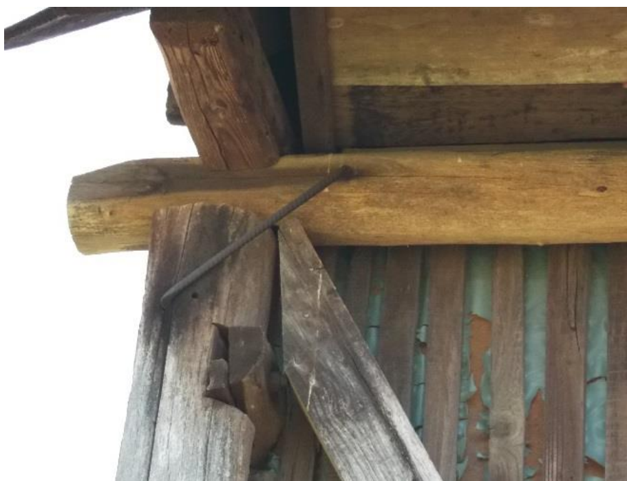
81. kép. Gerendák rögzítése ácskapoccsal
